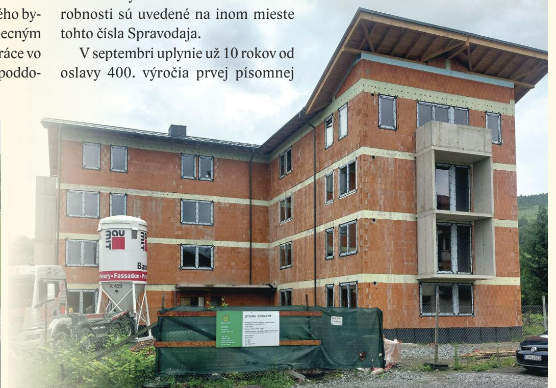
Práce na novom bytovom dome
