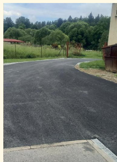
Asfaltovanie miestnych komunikácií
